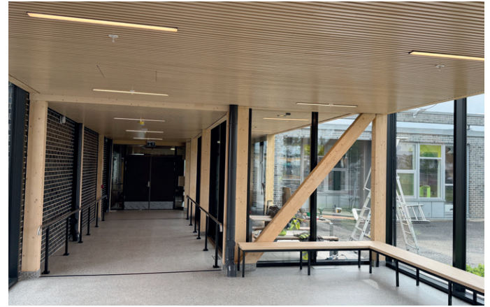
Det nye skolebygget er bygget sammen med eksisterende skolebygg med en innvendig gangforbindelse.
