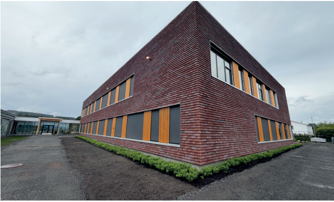
Utvidelsen av barneskolen omfatter et tilbygg på 2.082 kvadratmeter fordelt på to etasjer.
